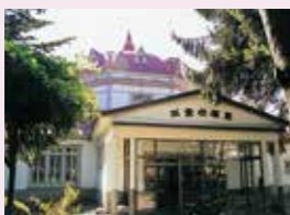
八角ドーム形の「旧双葉幼稚園園舎」はスピッツがライブをしたことも。建造年/大正11年(1922年)
