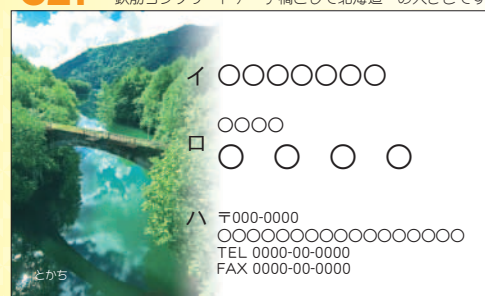
名刺番号 C21 上士幌町・第三音更川橋梁（北海道遺産・登録有形文化財） 鉄筋コンクリートアーチ橋として北海道一の大きさです。
